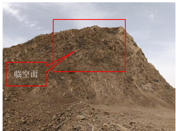
照片 3-4 露天采坑 CK2 现状
