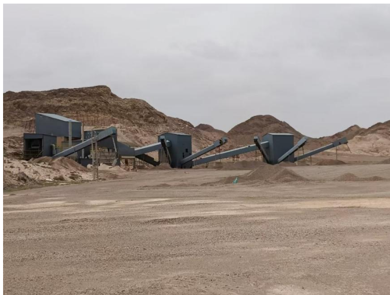
照片 3-5 一采区工业场地现状
