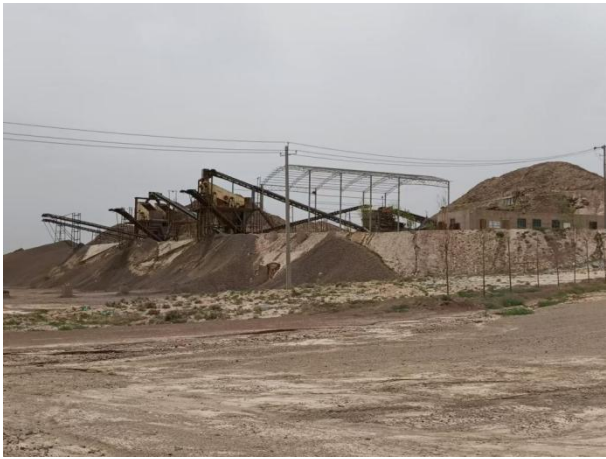
照片 3-6 二采区工业场地现状
